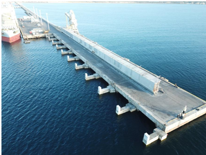
Sitio 2 Muelle Alte. Storni actualmente.
