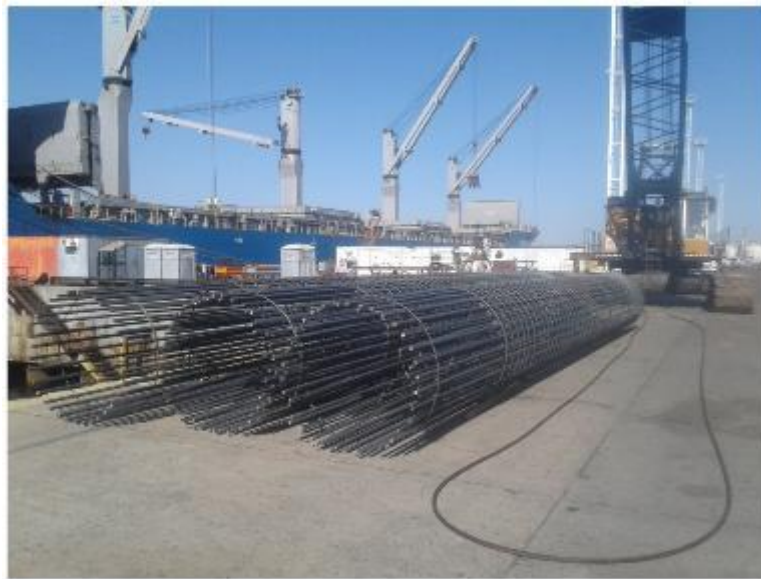
Armadura de pilotes
