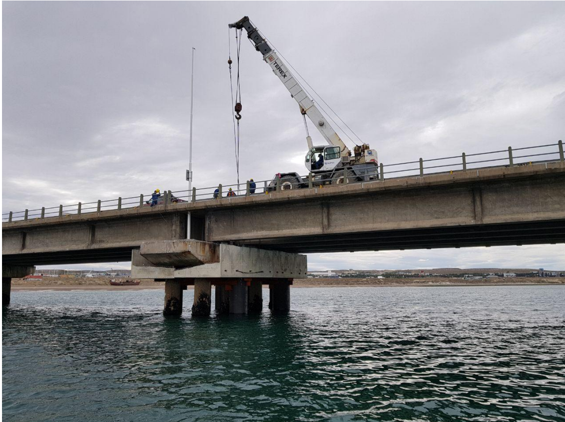
Montaje de premoldeados Cabezal N° 10 – Viaducto principal del Muelle Storni
