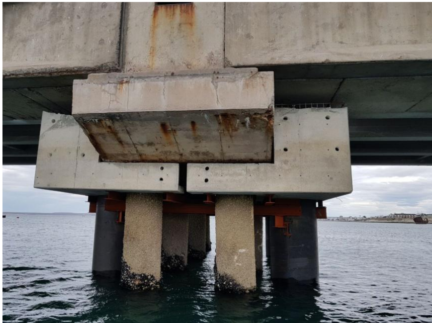
Premoldeados en su posición final – Cabezal N° 10 – Viaducto principal del Muelle Storni
