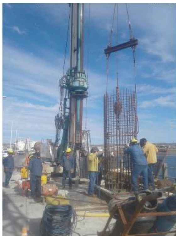
Ejecución de pilote de de diámetro \text{Ø}=1400\text{mm} (lado norte) en viaducto principal
