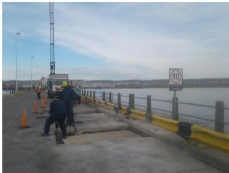
Demolición de calzada del viaducto principal
