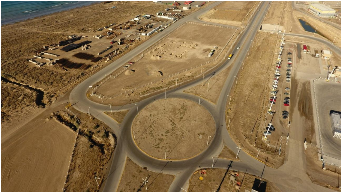
Vista aérea de la plazoleta de acopio Norte
