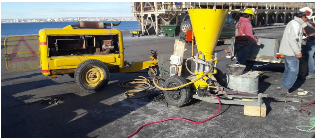
Foto 01 – Motocompresor, gunitadora y equipos menores.
